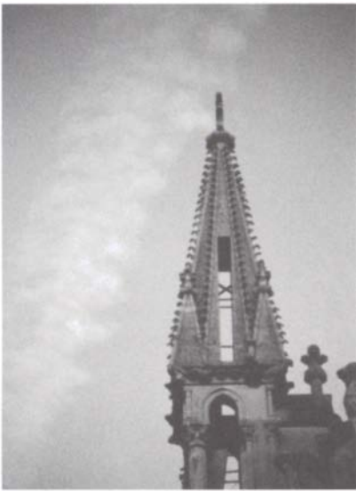
Figura 3 Pináculo vaciado para paliar el efecto negativo que produce el peso del pináculo sobre un contrafuerte que recibe un arbotante. Catedral de Reims.
