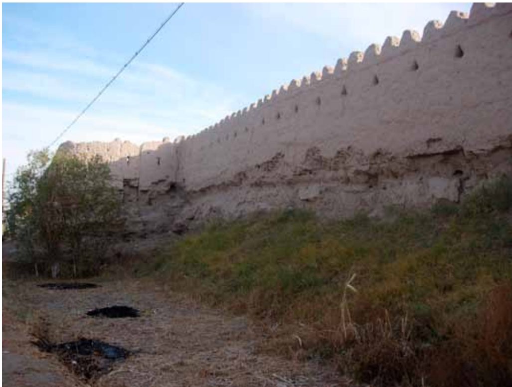
FIGURE 2 Vue du côté externe de la muraille de Deshan Kala. Le sillon de dégradation est bien visible à la base du mur. © LTHE
