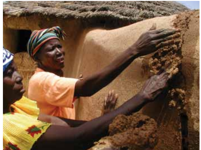
FIGURE 5 L'entretien des murs avant la fête du Ran Gnouga . © Direction générale du Patrimoine culturel du Burkina Faso. B. Kaboré
