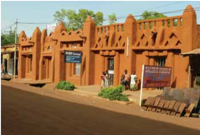
FIGURE 1 Tradition de construction en terre (banco rouge) à Ségou : la galerie d'art et d'artisanat de l'association Kasobane. Photo : L. Cissé, 2007
