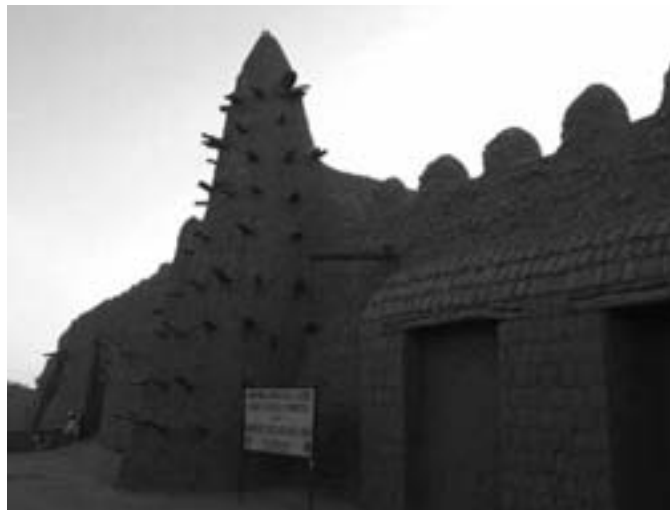
FIGURE 2 La célèbre mosquée Djingareyber à Tombouctou construite en 1325 par l'empereur Kankou Moussa à son retour du pèlerinage de la Mecque. Photo : L. Rainer, 2007
