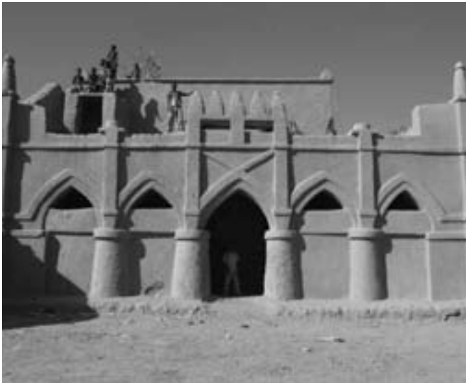
FIGURE 7 Architecture monumentale de Saho (Maison des Jeunes) à Kouakourou dans le Delta intérieur du Niger, non loin de Djenné. Un des monuments restaurés dans le cadre du projet néerlandais. Photo : L. Rainer, 2006
