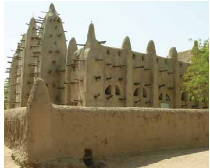
FIGURE 8 Édifice en terre à San (région de Ségou). Mosquée ancienne encore bien entretenue par les communautés locales. Photo : L. Cissé
