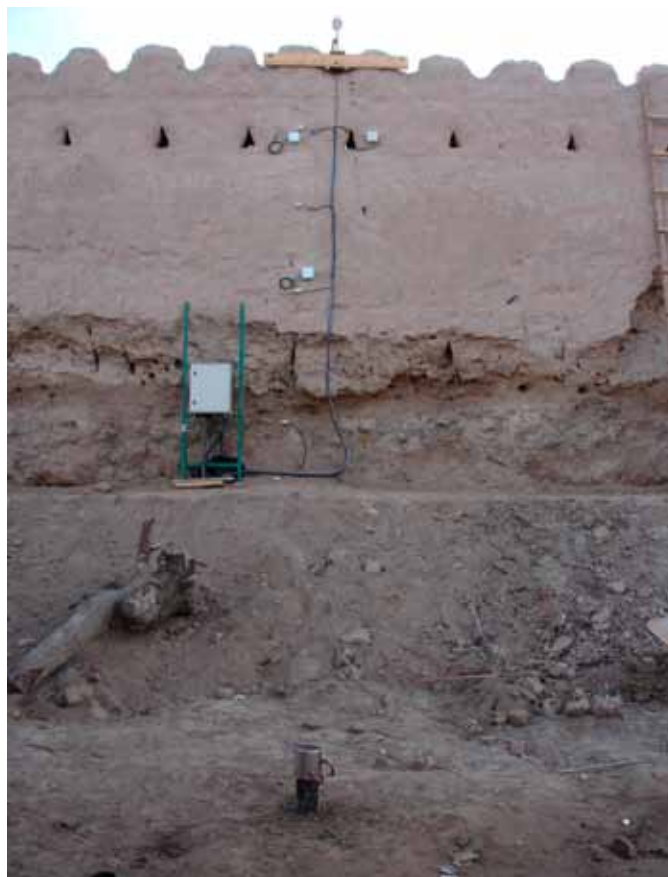
FIGURE 3 Vue du site d'étude. La station météorologique est installée au sommet du mur. Les capteurs d'humidité et de température placés dans le mur sont visibles, alors que ceux placés dans le sol sont enterrés. Au premier plan se trouve le piézomètre contenant les instruments mesurant le niveau et la salinité de la nappe. Tous les capteurs sont reliés à la centrale d'acquisition abritée dans le boîtier blanc qui stocke des données. © LTHE
