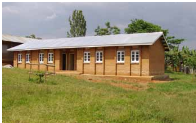
FIGURE 6 Prototype de construction contemporaine en blocs de terre comprimée, Bushenyi, Ouganda, 2005. Photo : Olivier Moles. © CRATerre
