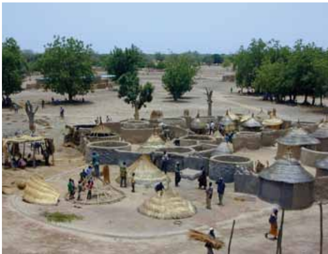
FIGURE 6 Le soukpilli , entretien traditionnel des toitures de la cour coutumière. © Direction générale du Patrimoine culturel du Burkina Faso. B. Kaboré
