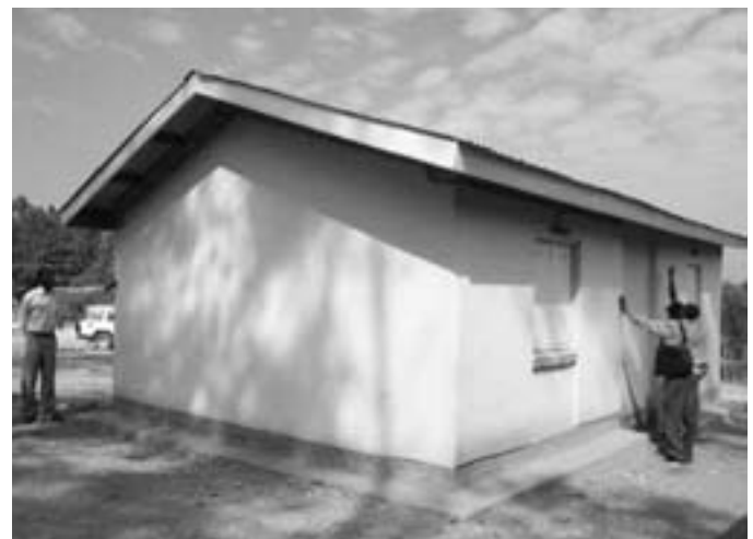
FIGURE 4 Prototype de construction contemporaine en torchis à Bushenyi, Ouganda, 2005. Photo : Olivier Moles. © CRATerre
