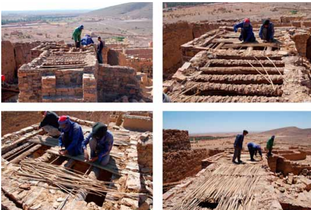
FIGURE 4 Compétence d'édifier, retrouver les gestes. La charpente très simple est constituée de stipes de palmier de section rectangulaire ou triangulaire, très rapprochées. Ces solives portent perpendiculairement au mur, le voligeage est constitué de tiges de palmes. Un lattis serré de branches de laurier ou de palmes sèches est ensuite recouvert de palmes entières fraîchement cueillies, apportées et déposées sur cette structure, de sorte que le mortier final, répandu au-dessus ne passe à travers. Une fois les interstices ainsi comblés, on peut répandre le mortier de couverture, préalablement malaxée au pied. Photos © S. Naji
