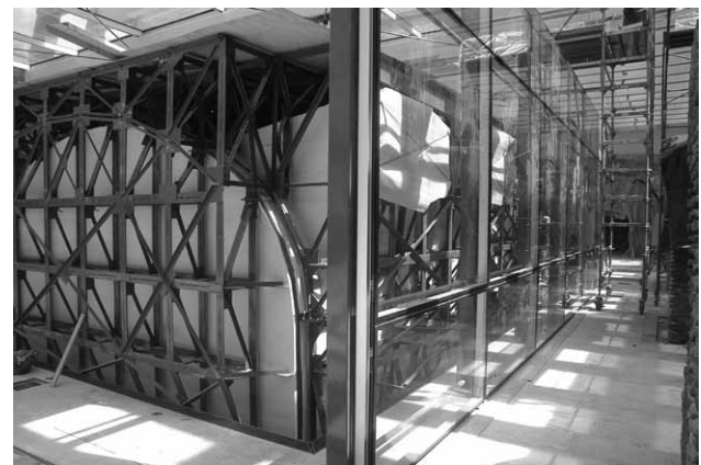
Figura 7 Instalación del mural en un recinto de vidrio en el Museo del Bicentenario. Foto: Néstor Barrio
