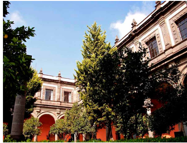
Figura 1 Vista Patio Interior. Centro Nacional de Conservación y Registro del Patrimonio Artístico Mueble. México D.F. Foto: CENCROPAM-INBA
