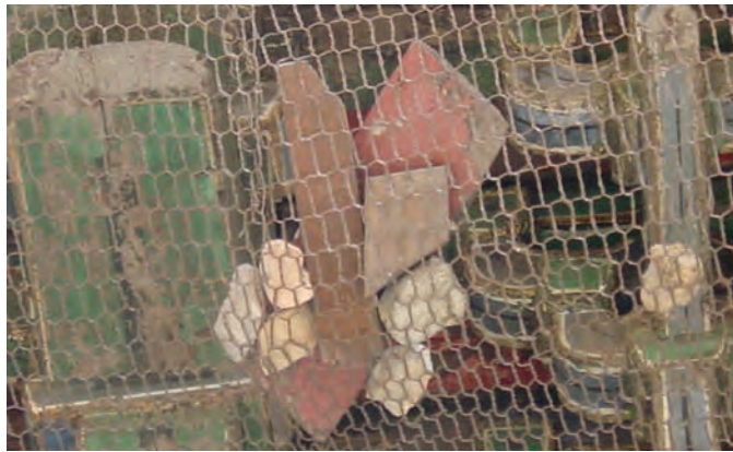
在鸟网中经常可见斗拱构件，（包括脱落的彩画）及从垫拱板与檩子脱落的彩画。
