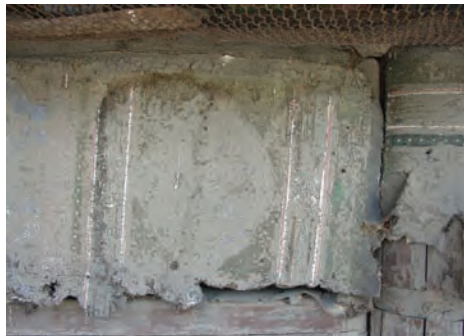
2004年5月东次间彩画局部开始下垂区域显示初步的退化。这一区域现已脱落。
