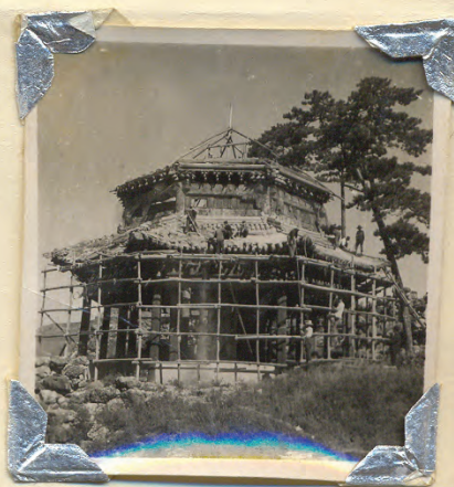
2. 维修情况 前正面 版号 7. 1959. 7.
