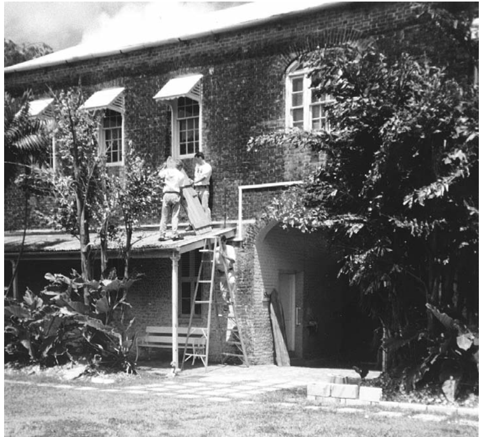
Figure 7 Le personnel du service des bâtiments et de l'entretien du Musée et Société historique de La Barbade pose des volets sur les fenêtres du bâtiment pour le protéger contre un ouragan qui approche. Photo d'Alissandra Cummins, gracieusement fournie par le musée.
