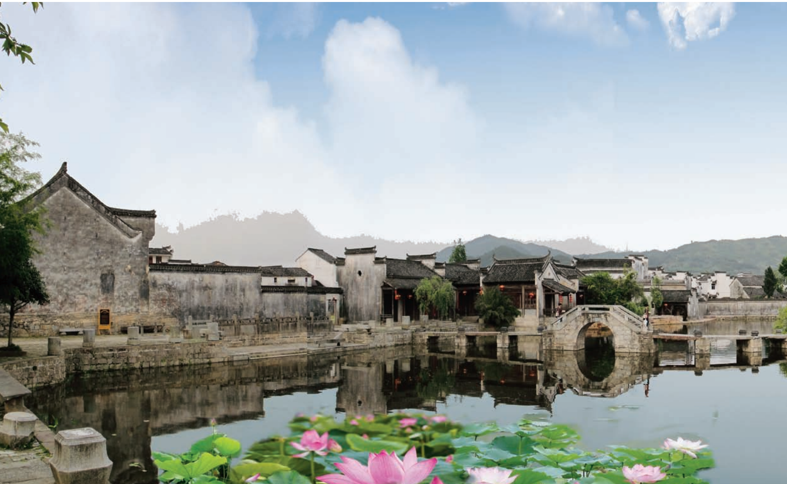
安徽黄山呈坎村 Chengkan Village, Huangshan, Anhui Province
