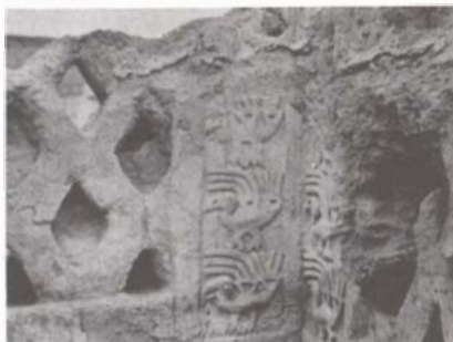
Friso con figuras en relieve en la ciudad pre-hispánica de Chanchán, tratados con silicato de etilo.
