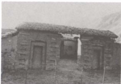
Palacio de época Inca existente en Yucay cerca de Cusco, restaurado con criterios adecuados en 1976.
