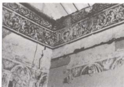
Bautisterio de la iglesia de Oropesa durante el proceso de recuperación de la pintura mural del siglo XVII, cubierta con estuco.
