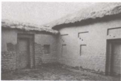
Interior del mismo palacio mostrando la diferencia entre lo original y lo re- puesto esquemáticamente, en base a las evidencias arqueológicas (a la derecha).
