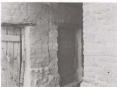
FIG. 23 Le même ensemble une fois édifié et recouvert d'enduit. Photo J.C.-L.
