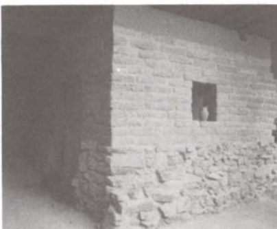
FIG. 18 Élévations de briques crues sur soubassement de pierres. Parements dénués de revêtement. Photo J.C-L.
