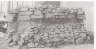
FIG. 13 Maçonnerie de pierres et de briques avant restauration. Superposition de deux murs successifs. Photo J.C-L.
