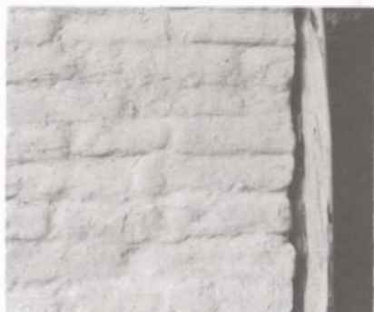
FIG. 21 Détail d'un enduit extérieur renforcé de végétaux. Photo J.C.-L.
