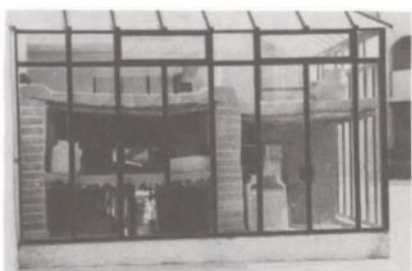
FIG. 27 Vue extérieure en coupe de deux maisons reconstituées. Toits terrasses et mezzanines. Photo J.C-L.
