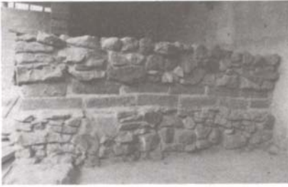
FIG. 14 La même maçonnerie après restauration. Photo J.C-L.
