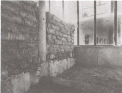
FIG. 16 Masquage par le mur de briques crues d'un pilier d'angle en béton de la "Vitrine Archéologique". Photo J.C-L.
