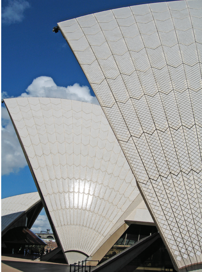
FIGURAS 4A–4E Ejemplos de acabados de hormigón: (a) revestimiento con azulejos sobre hormigón, Ópera de Sídney, Jørn Utzon, Sídney, Australia, 1973. Fotografía: Greg O’Beirne, 2006, bajo licencia CC BY-SA 3.0 Unported; (b) hormigón abujardado, Barbican Centre, Chamberlin, Powell & Bon, Londres, Reino Unido, 1976. Fotografía: Ana Paula Arato Gonçalves, 2019, © J. Paul Getty Trust; (c) hormigón estriado con agregado visto. Fotografía: Ana Paula Arato Gonçalves, 2019, © J. Paul Getty Trust; (d) hormigón tableado. Fotografía: Ana Paula Arato Gonçalves, 2019, © J. Paul Getty Trust; y (e) hormigón imitación piedra, Palais d’Iéna, Auguste Perret, París, Francia, 1937–46. Fotografía: Ana Paula Arato Gonçalves, 2018, © J. Paul Getty Trust.
